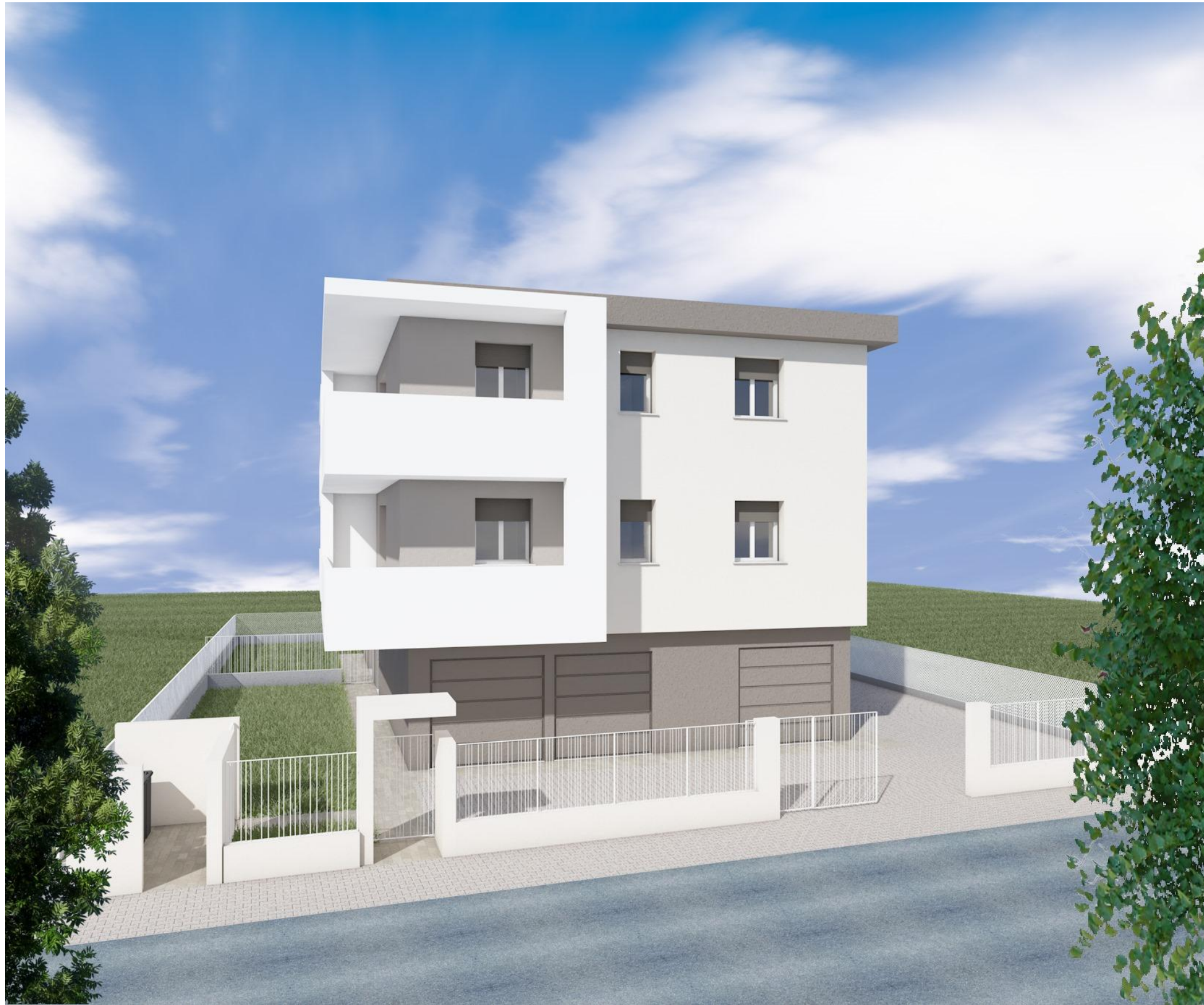
VISTA DA STRADA
