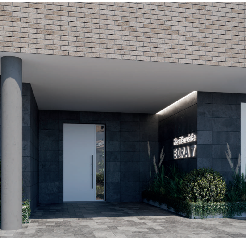
DETTAGLIO DELL'INGRESSO CONDOMINIALE
